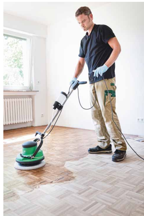
Práce s 2K olej na dřevo a FloorXcentr
